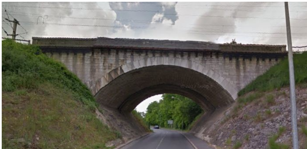
VISUEL N° 2 : Passage sous la voie ferrée, cote 101
